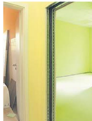
Fröhliche Farben dominieren das Innere des Gebäudes.
