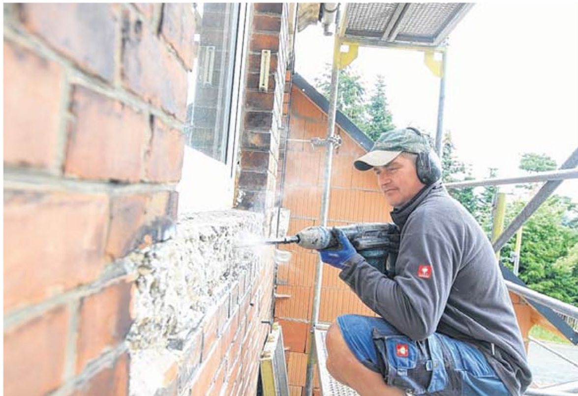
René Pömpner legt an der Fassade der ehemaligen Schule in Syrau Hand an, damit dort möglichst bald wieder Mädchen und Jungen einziehen. Denn dort entsteht der Kindergarten für den Ort.
